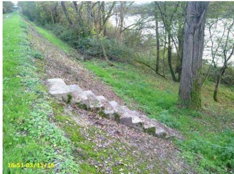
**Figure 2 : parement bétonné sur le haut du talus coté Loire avec escalier en béton (vu vers l'amont) et végétation arbustive en pied de talus**
