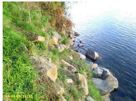
**Figure 5 : protection de la berge en enrochements libres avec quelques blocs déstabilisés**
