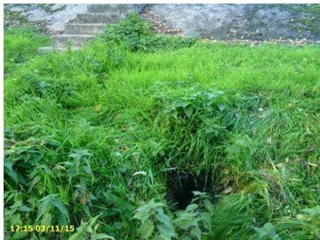
**Figure 4 : terrier de diamètre supérieur à 30cm en milieu de talus coté Loire (sous parement bétonné)**
