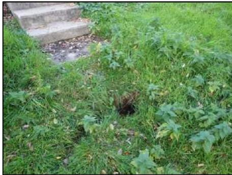
Afin de pérenniser le système d'endiguement sur ce linéaire, il est recommandé d'araser la digue et de la reconstruire conformément aux règles de l'art.
