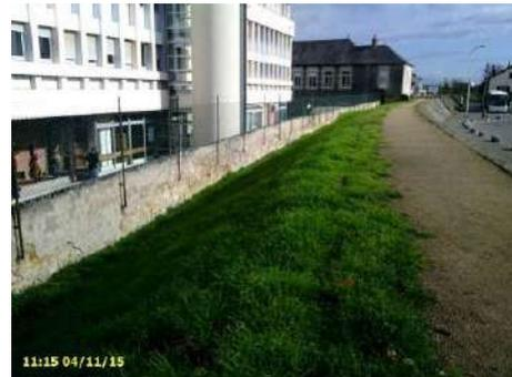
Les travaux recommandés consistent à mettre en œuvre un système de drainage du corps de la digue et de la fondation du mur de soutènement et de la périphérie immédiate de l'ouvrage encastré.
