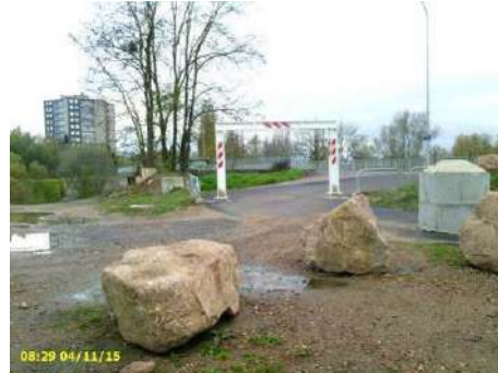
Figure 13 : raccordement aval de la levée au remblai de la route départementale
