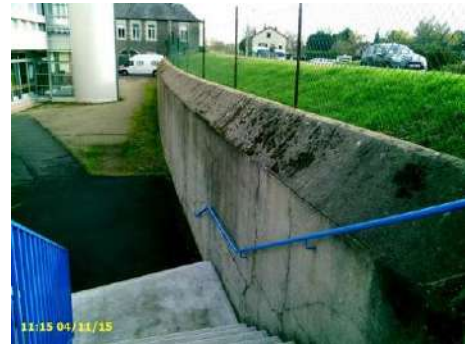
Figure 104 : Mur de soutènement au droit du bâtiment de la DDT58 vu vers l'amont
