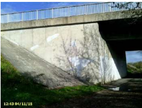
Figure 35 : culée du pont de la route départementale encastrée dans la digue, vue vers l'amont
