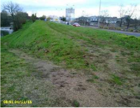
Figure 14 : vue de la digue vers l'amont avec rampe d'accès vers la risberme coté canal
