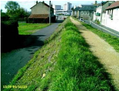
Figure 43 : talus coté Loire perré avec crête étroite (non circulaire) vu vers l'aval
