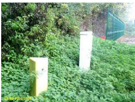
Figure 94 : Bornes signalant la présence de conduite de gaz qui traverse l'ouvrage dans la portion aval de la levée de Maison Rouge
