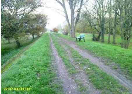
Figure 10 : levée vue vers l'amont avec banc installé en crête
