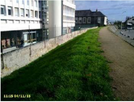
Figure 47 : digue vue vers l'amont avec mur de soutènement sur talus coté val
