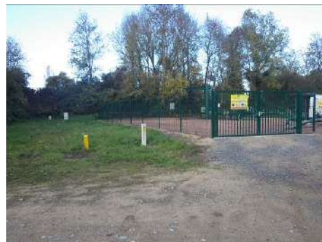
Figure 5 : poste de gaz en pied de talus coté Loire de la digue Maison Rouge avec canalisation traversant la digue
