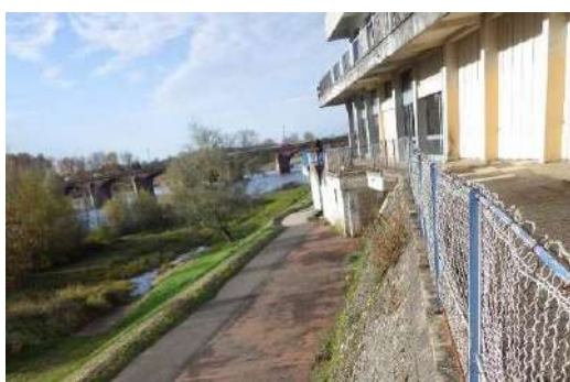
Figure 99 : Maison de la Culture vue vers l'aval depuis la crête de l'ouvrage : Bâtiment encastré sur talus côté val et escalier d'accès reposant sur perré côté Loire
