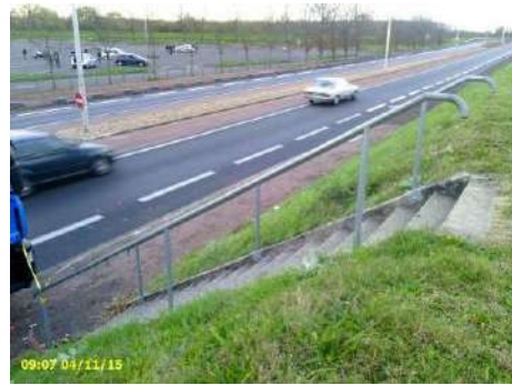
Figure 17 : digue vue vers l'aval avec escalier en béton et route départementale en pied de talus
