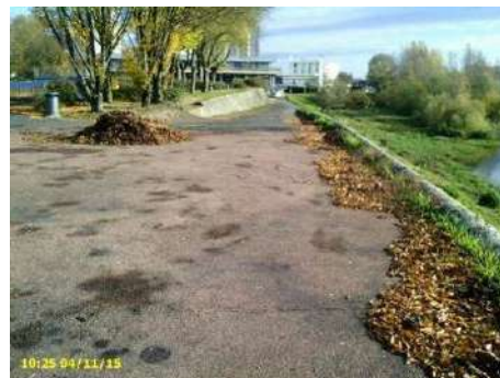
Figure 68 : rampe d'accès au pied de talus coté Loire en aval de la levée de Médine
