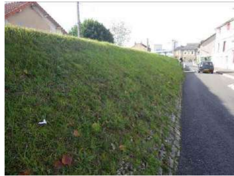
Figure 44 : talus coté val perré vu vers l'aval
