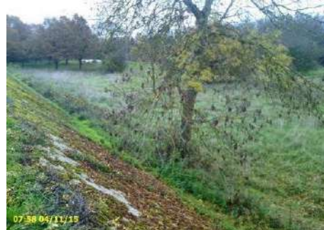
Figure 11 : parement renforcé sur haut de talus coté Loire avec arbre isolé en pied (vu vers l'amont)
