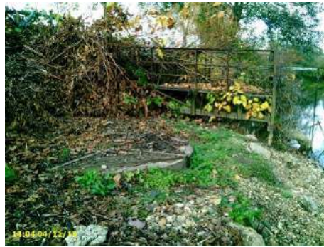
Figure 74 : Pt76 - Ancienne station de pompage de l'usine Thompson – ATB Selni (clapet étanche ?)
