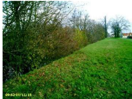
Figure 19 : raccordement de la digue au TN vu vers l'aval avec végétation sur haut de talus
