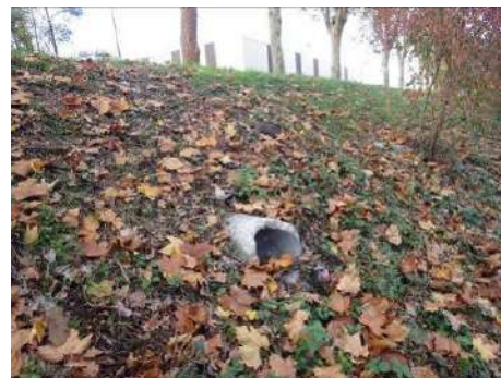
Figure 26 : ouvrage hydraulique traversant ouvert ( ? ) vu en milieu de talus coté canal
