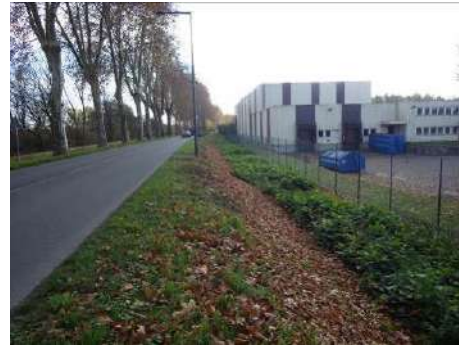
Figure 22 : talus coté val vue vers l'aval avec route et alignement de platanes en crête
