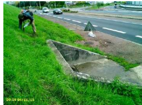
Figure 106 : Mur de soutènement pour canalisations en pied de talus coté val vu vers l'amont (au nombre de 3 au total sur digue rive gauche canal)
