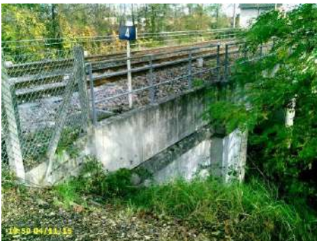
Figure 33 : culée du pont de la voie ferrée vue sur sa face aval
