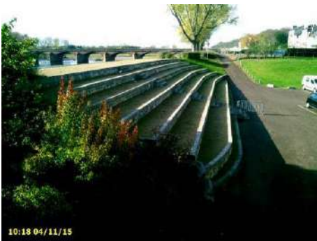
Figure 53 : talus coté val avec gradins béton vu vers l'aval avant raccordement au coteau
