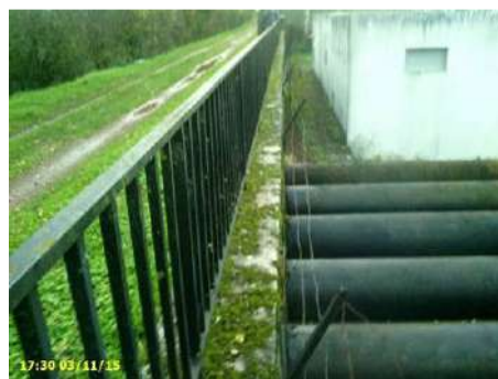
Figure 95 : Six canalisations traversant la levée de St-Eloi 2ème section en milieu de talus coté val (station de relevage de la Baratte) avec renforcement visible en palplanches couronnées d'une poutre en béton
