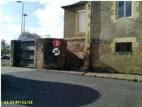
Figure 57 : Porte de Médine vue vers l'aval depuis le côté val avec maison encastrée
