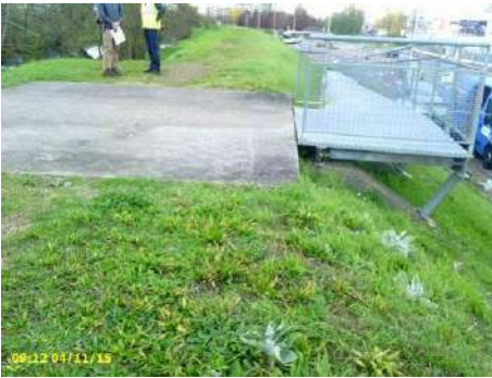
Figure 16 : rampe d'accès à la passerelle sur talus coté val avec plots d'ancrage dans l'ouvrage en béton (vue vers l'amont)
