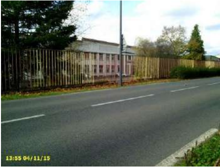
Figure 27 : route en crête vue vers l'amont avec mur de soutènement sur talus coté val surmonté de grilles métalliques
