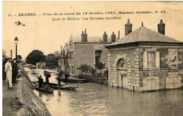
Figure 171 : Photo en aval de la levée de Médine lors de la crue de 1907 (EGRIAN 2010)
