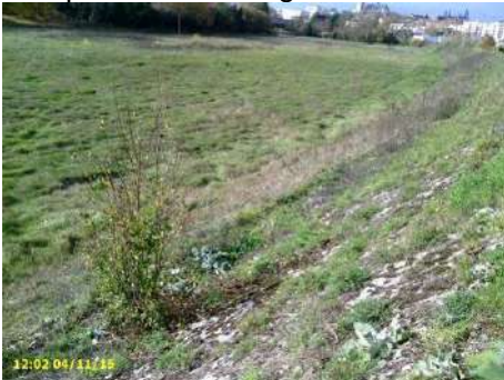
Figure 37 : talus coté Loire avec renforcement béton vu vers l'aval
