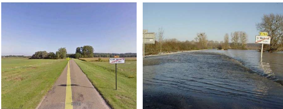
Figure 175 : déversoir de Saint-Martin-sur-Ocre aujourd'hui (à gauche) et lors de la crue de décembre 2003 (à droite) (image Google Earth – crédit photo DREAL Centre)
