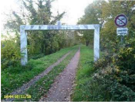
Figure 63 : portique d'accès au niveau du raccordement de la levée de Maison Rouge et de la levée 2ème section de St-Eloi
