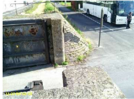
Figure 56 : Vue vers l'amont de la porte de Médine depuis la crête côté aval de l'ouvrage
