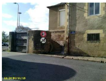
Figure 98 : Porte de Médine vue depuis le côté val avec maison encastrée sur talus côté val
