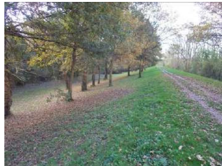
Figure 7 : végétation clairsemée sur talus coté val (vue vers l'amont)
