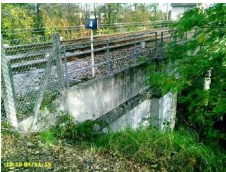
Figure 111 : Culée en aval du pont de la voie ferrée coté levée rive droite du canal de dérivation
