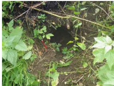
Figure 118 : Terrier de 20cm de diamètre dans talus coté val sous mur de soutènement (tronçon VTA n°7)
