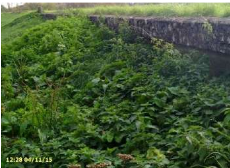
Figure 41 : mur de soutènement sur le haut de talus coté val vu vers l'amont - pk2750
