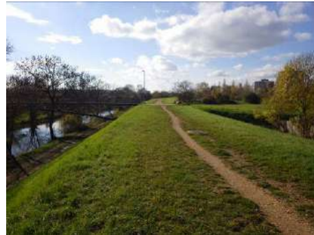
Figure 32 : digue vue vers l'aval à proximité de la passerelle
