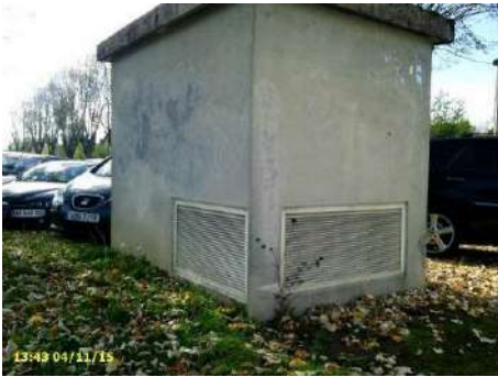
Figure 101 : Poste EDF en crête de l'ouvrage en amont du pont de la RN.81 sur levée coté rive droite du canal
