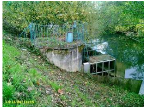
Figure 73 : Pt64 - Ancienne station de pompage de l'usine Mazda (clapet étanche ?)
