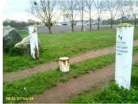
Figure 64 : borne limitant l'accès en aval de la levée St-Eloi 2ème section
