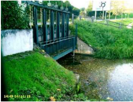
Figure 21 : martelières sur ancienne Nièvre vues vers l'amont et vers le raccordement de l'ouvrage au coteau
