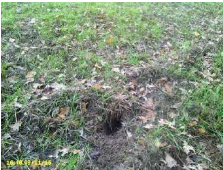
Figure 115 : Terrier de 5cm de diamètre sur haut du talus coté val (tronçon VTA n°1 – Val Est)
