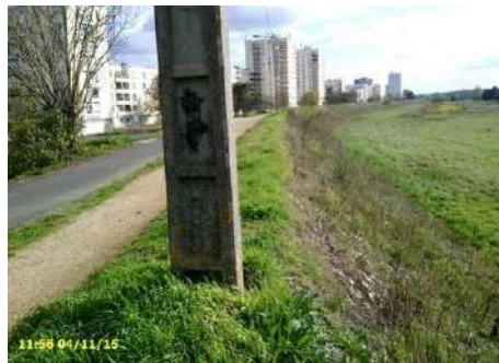
Figure 40 : pylônes béton en crête de la levée vus vers l'amont
