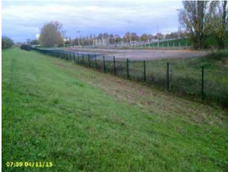
Figure 12 : clôture grillagée sur terrain naturel coté val (vue vers l'aval)
