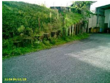
Figure 50 : début du renforcement en palplanches en pied de talus coté val et gagnant l'axe de l'ouvrage vers l'aval
