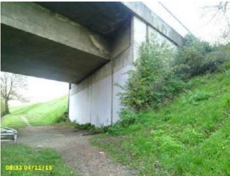
Figure 18 : culée du pont de la route départementale encastrée dans la digue vue vers l'amont
