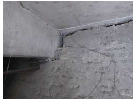
Figure 102 : Poutre de béton encastrée sur haut du talus coté Loire au niveau de l'hôtel
