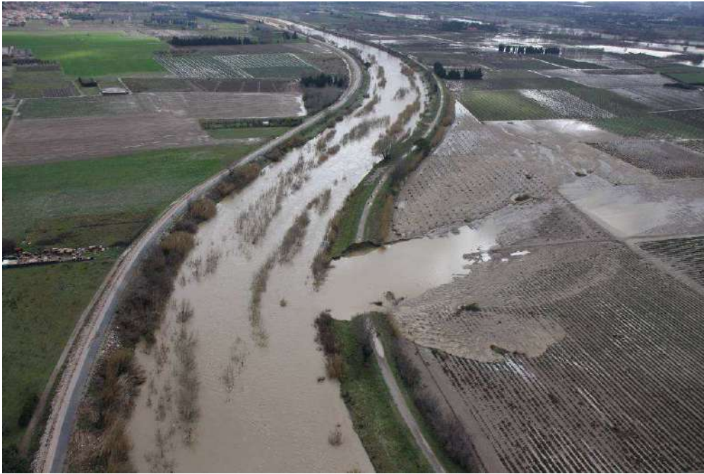
Figure 176 : brèche de Pia sur l'Agly – crue du 6 mars 2013 – (photo : protection civile des Pyrénées-Orientales)
