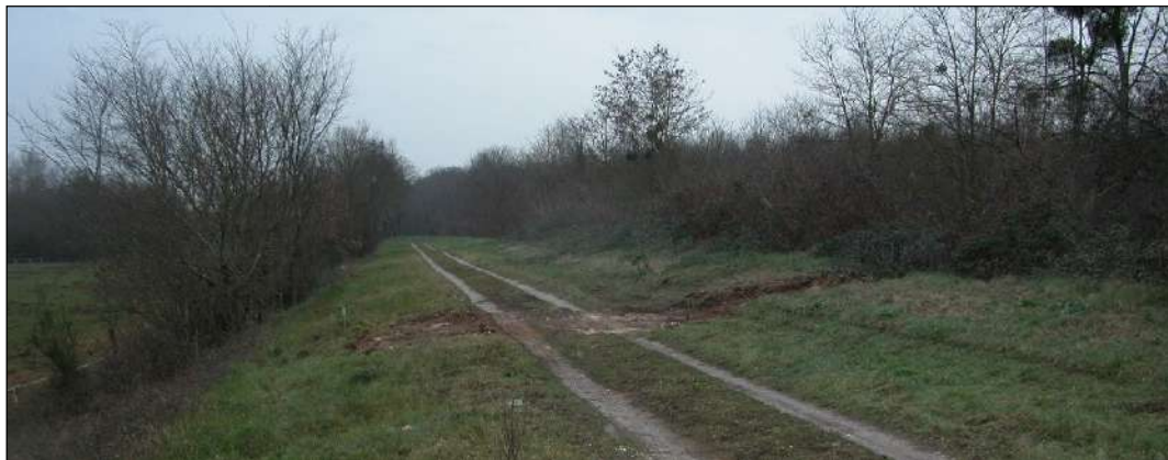
Figure 173 : levée de Beffes-Herry - réparations d'urgence lors de la crue de décembre 2003 (crédit photo DREAL Centre)
