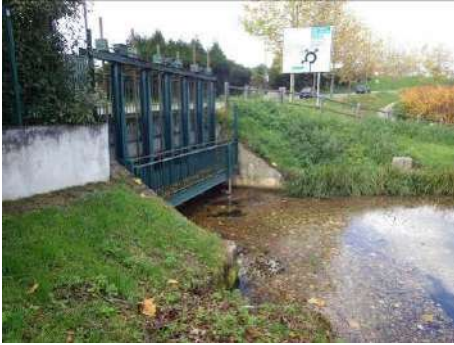
Figure 70 : Pt162 - Ouvrage hydraulique avec martelières au niveau du raccordement de la levée rive droite du canal de dérivation avec le coteau
