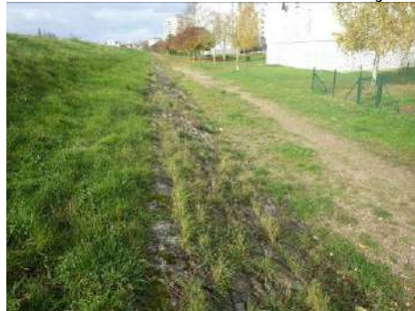
Figure 38 : perré visible en pied de talus coté val vu vers l'aval
