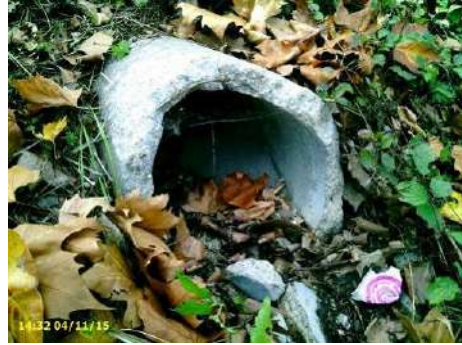
Figure 71 : Pt78 - Ouvrage hydraulique ouverte pour rejet eaux pluviales au milieu de talus coté canal (levée rive droite du canal de dérivation) – fil d'eau 177.81mNGF
