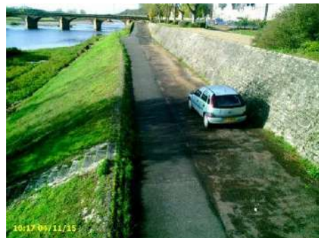
Figure 52 : perrés sur talus coté Loire en aval de la Maison de la Culture (vus vers l'aval)
