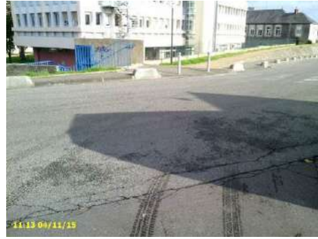
Figure 48 : route passant en crête de l'ouvrage entre l'hôtel et la DDT58 (vue vers l'amont)
