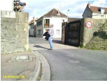
Figure 55 : Porte de Médine vue depuis le côté Loire vers le côté val avec renforcement maçonné de part et d'autre
