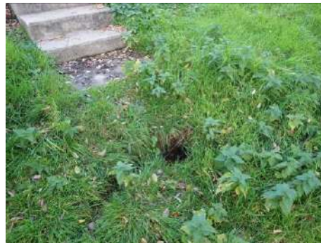
Figure 116 : Terrier de 20cm de diamètre dans le bas du talus coté Loire (tronçon VTA n°1)
