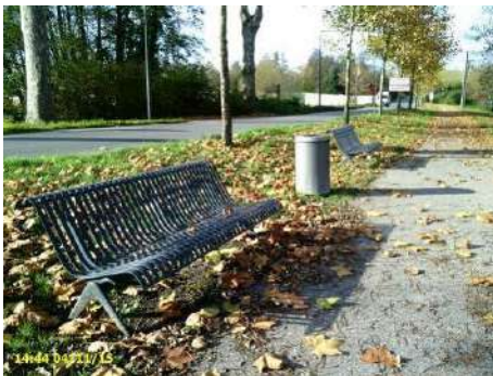
Figure 23 : crête de la digue avec bancs et poubelle vue vers l'amont
