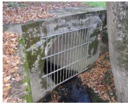
Figure 77 : Pt72 - Ouvrage hydraulique avec buse rejetant en pied de talus coté Loire les eaux pluviales de la station de relevage de la Baratte
