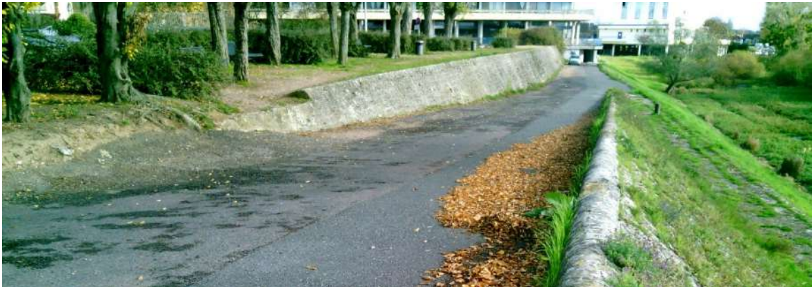
Figure 152 : Photo du raccordement de la digue au terrain naturel
