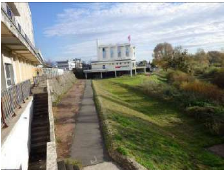
Figure 51 : Bâtiment de la Maison de la Culture encastré au premier plan, avec perrés sur talus coté Loire se prolongeant sous la terrasse de l'hôtel visible en arrière-plan (vu vers l'amont)
