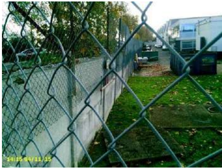
Figure 103 : Mur de soutènement vu vers l'aval sur talus coté val au droit des usines
