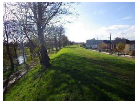
Figure 36 : végétation clairsemée sur talus coté canal vue vers l'aval
