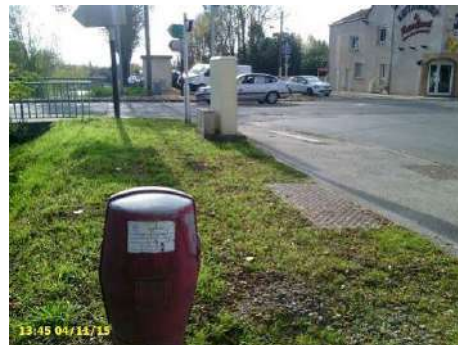
Figure 34 : nombreux réseaux visibles au droit du pont de la RN81 (vus vers l'aval)
