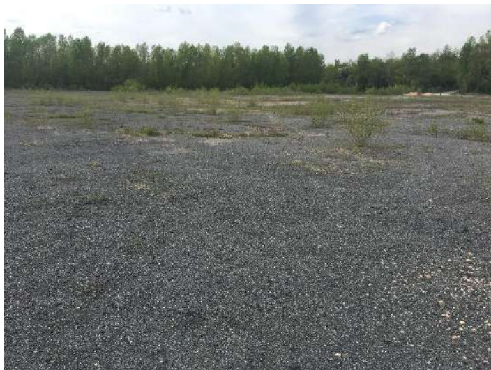
Photo 8 : Plateforme stabilisée (in situ IEA)
