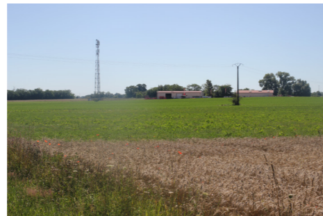
Bâtiments d'activités Source : ARTIFEX 2022
