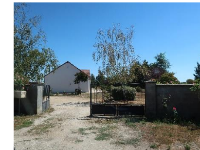
Habitation du lieu-dit « Cocheriot » Source : ARTIFEX 08/2022
