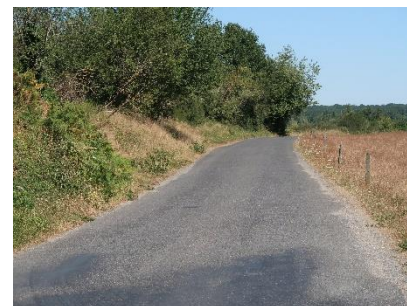
Route des Rosiers Source : ARTIFEX 08/2022
