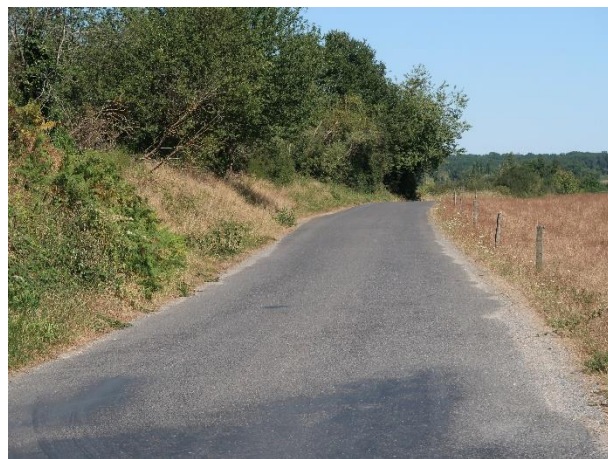
Route des Rosiers Source : ARTIFEX 08/2022
