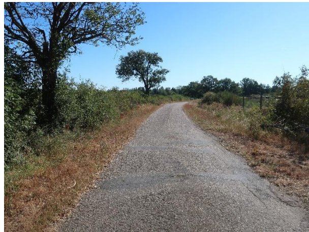
Voie communale n°12 du Riot à Mussy en limite Nord de la partie A Source : ARTIFEX 08/2022
