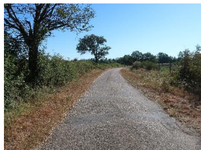
Voie communale n°12 du Riot à Mussy en limite Nord de la partie A Source : ARTIFEX 08/2022
