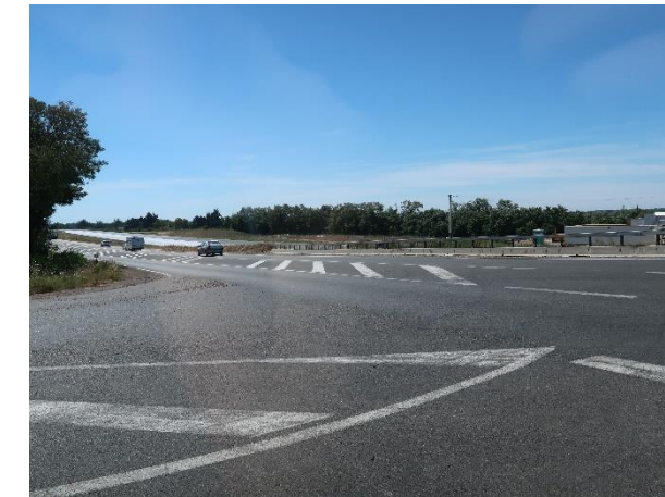
Route nationale N7 Source : ARTIFEX 08/2022
