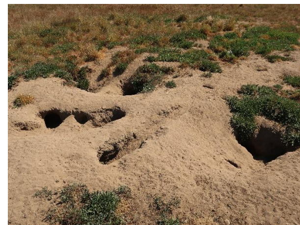
Trous au droit de la partie C Source : ARTIFEX 08/2022
