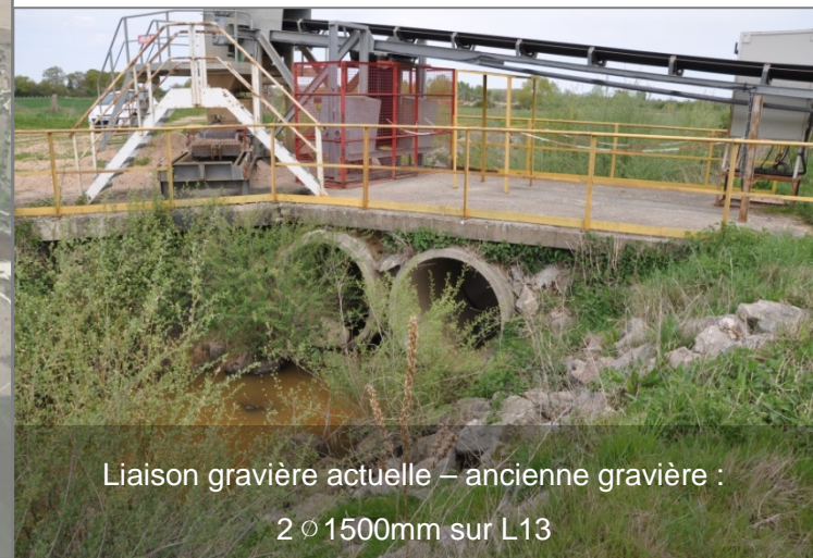
Figure 3-8 : Liaison gravière actuelle – ancienne gravière (2Ø 1500mm sur L13)
