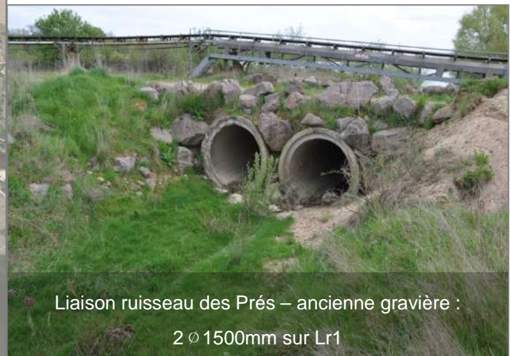
Figure 3-6 : Liaison ruisseau des Prés – ancienne gravière (2 Ø 1500mm sur Lr1)
