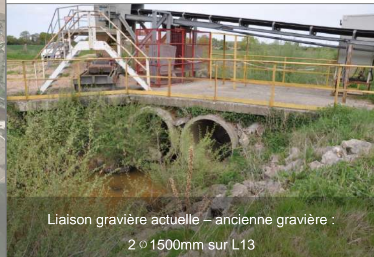
Figure 3-8 : Liaison gravière actuelle – ancienne gravière (2Ø 1500mm sur L13)
