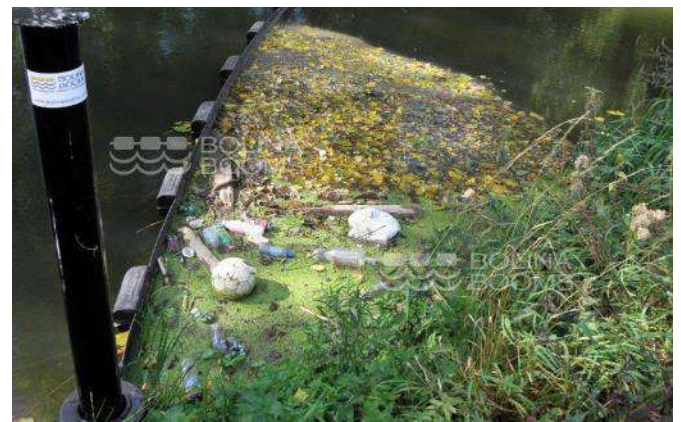
Figure 40: Exemple de dromes retenant des débris
