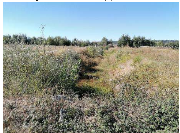
Figure 9: P6 - Canal de connexion entre les bassins A et C
