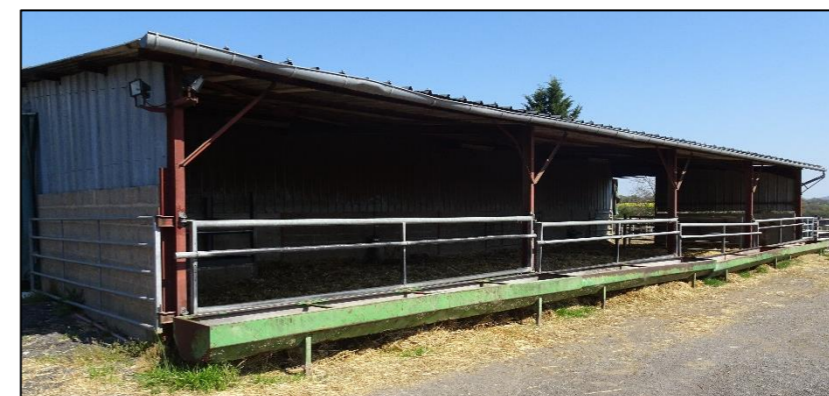
Photographie 12 : Second bâtiment à destination des taureaux (source : ENCIS Environnement)
