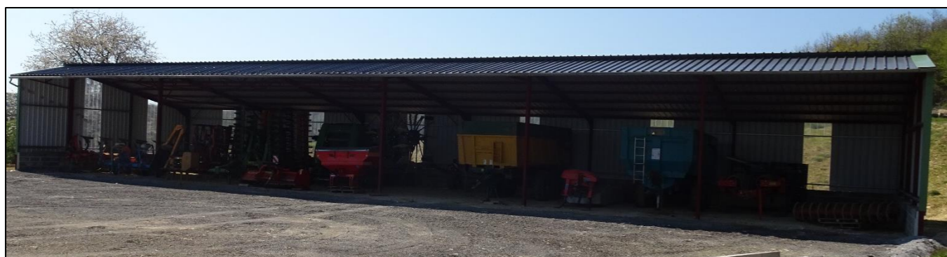
Photographie 15 : Hangar récent utilisé pour le stockage du matériel, situé au sud de la ferme (source : ENCIS Environnement)
