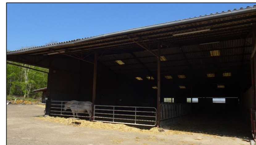
Photographie 11 : Bâtiment pouvant accueillir les taureaux (à gauche) (source : ENCIS Environnement)
