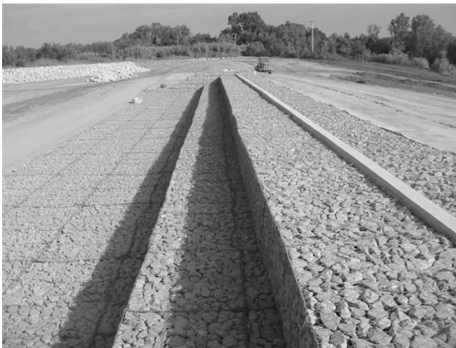
FIGURE 7 : ÉCHANCRURE DU DÉVERSOIR DE LUNEL EN GABIONS
