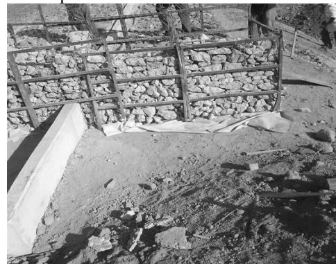
FIGURE 15 : CONTINUITÉ DE LA POUTRE SOMMITALE AU-DELÀ DU BAJOYER EN GABIONS (EN COURS DE RÉALISATION) – LUNEL
