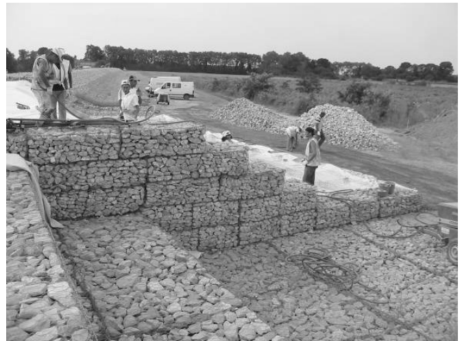
FIGURE 11 : EXEMPLE DE BAJOYER – ÉCHANCRURE DU DÉVERSOIR DE LUNEL
