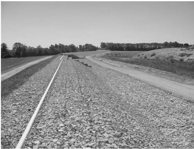
FIGURE 5 : DÉVERSOIR DE LUNEL EN MATELAS DE GABIONS
