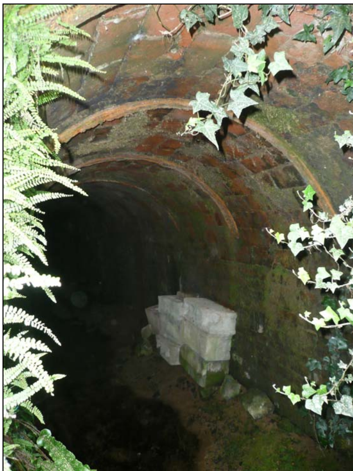
Illustration 14 - Entrée de la carrière souterraine de Saint-Léger-Les-Vignes (Photo BRGM).
