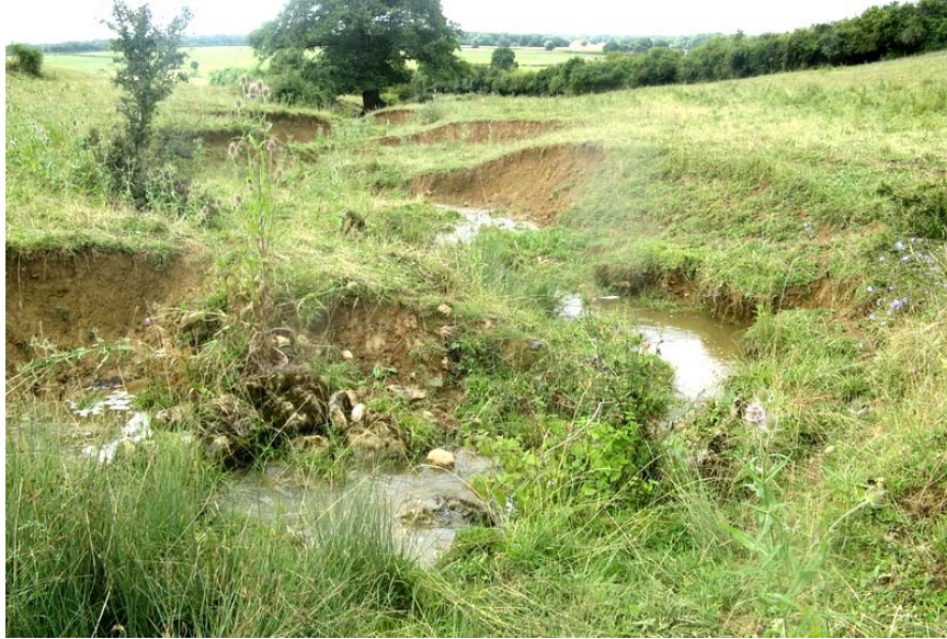
Illustration 20 : érosion de berge dans la Nièvre (photo BRGM).
