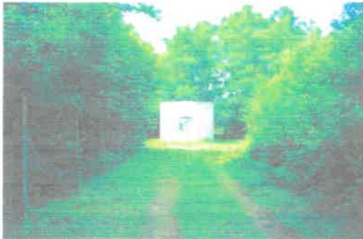
Vue sur le périmètre immédiat
