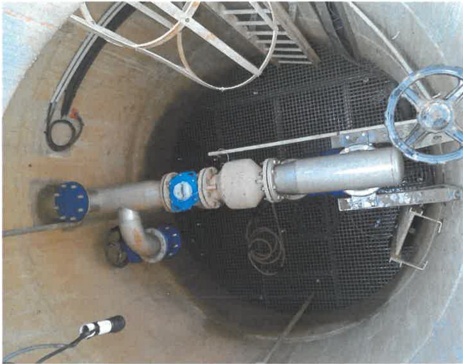
Figure 62 : Vue de l'intérieur d'un puits existant
