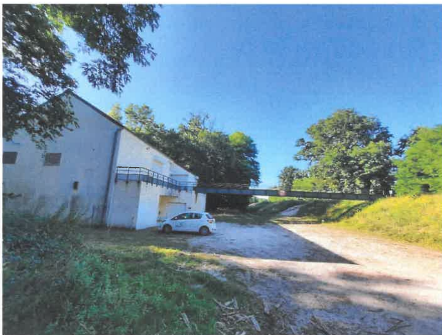
Figure 44 : Vue de la passerelle depuis le chemin
