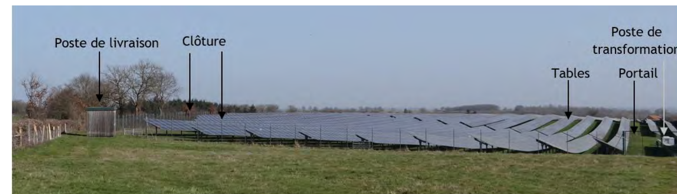
Figure 115 : Exemple de centrale photovoltaïque au sol existante avec poste de livraison et postes de transformation en vue immédiate dans un contexte bocager
