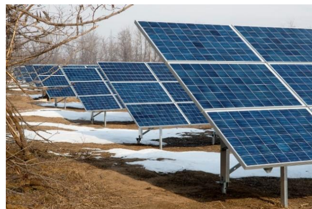
Figure 2 : Exemple d'une centrale photovoltaïque en Roumanie (50 MW)
