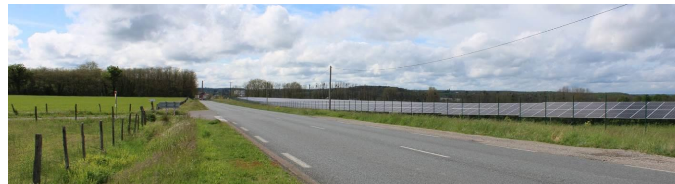
Photo 32 : Le parc photovoltaïque sur la zone du Four à Chaux
