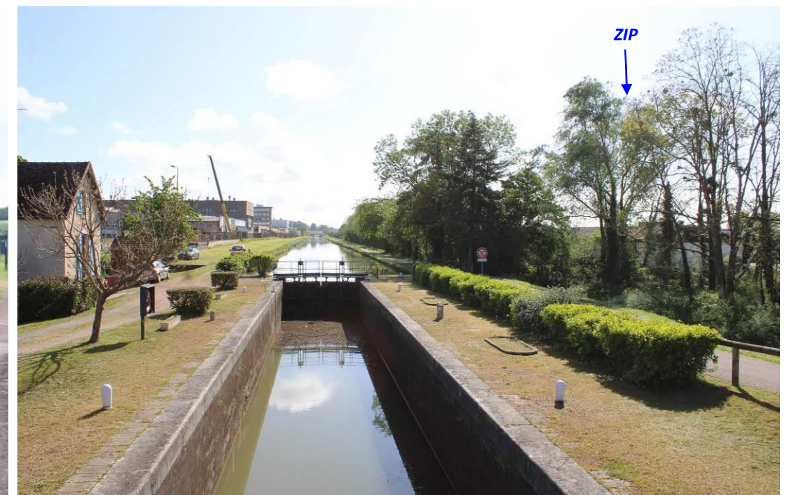
L'écluse n°34 de Vauzelles sur le Canal du Nivernais à Decize
