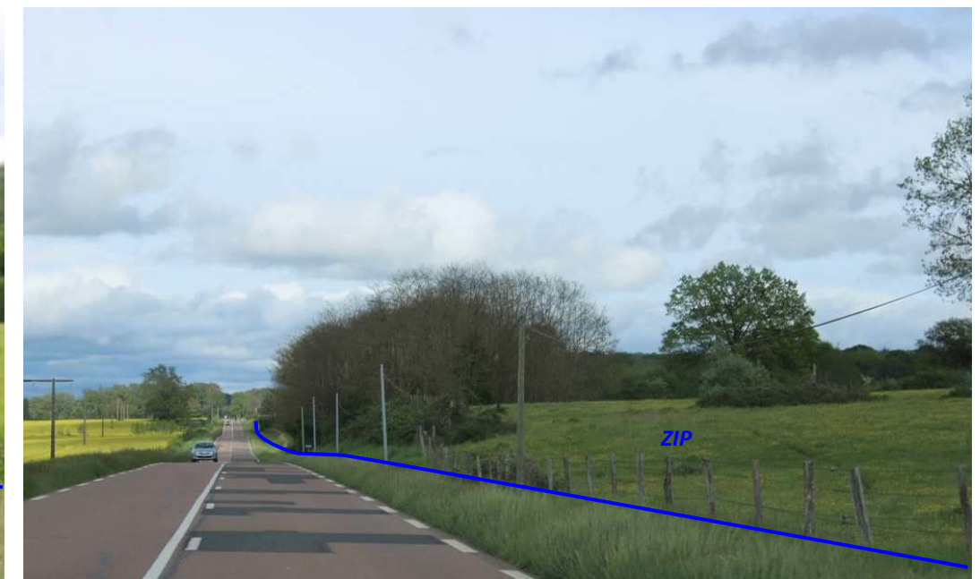
Vue 33 : Le parcours alterne entre ouvertures et fermetures visuelles sur la ZIP dont parfois celle-ci se situe en contre-haut de la chaussée.
