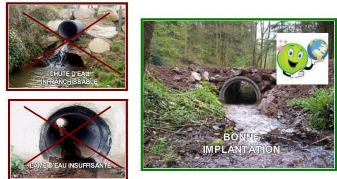
Figure 72 : Bonne implantation d'une buse sur un cours d'eau<sup>68</sup>
