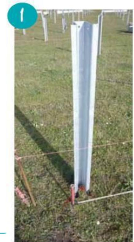
Figure 64 : Extraits du guide de l'étude d'impact des parcs photovoltaïques : l'utilisation de pieux pour les fondations destinées à soutenir les supports des panneaux présente l'avantage de réduire les impacts sur l'imperméabilisation des sols.
