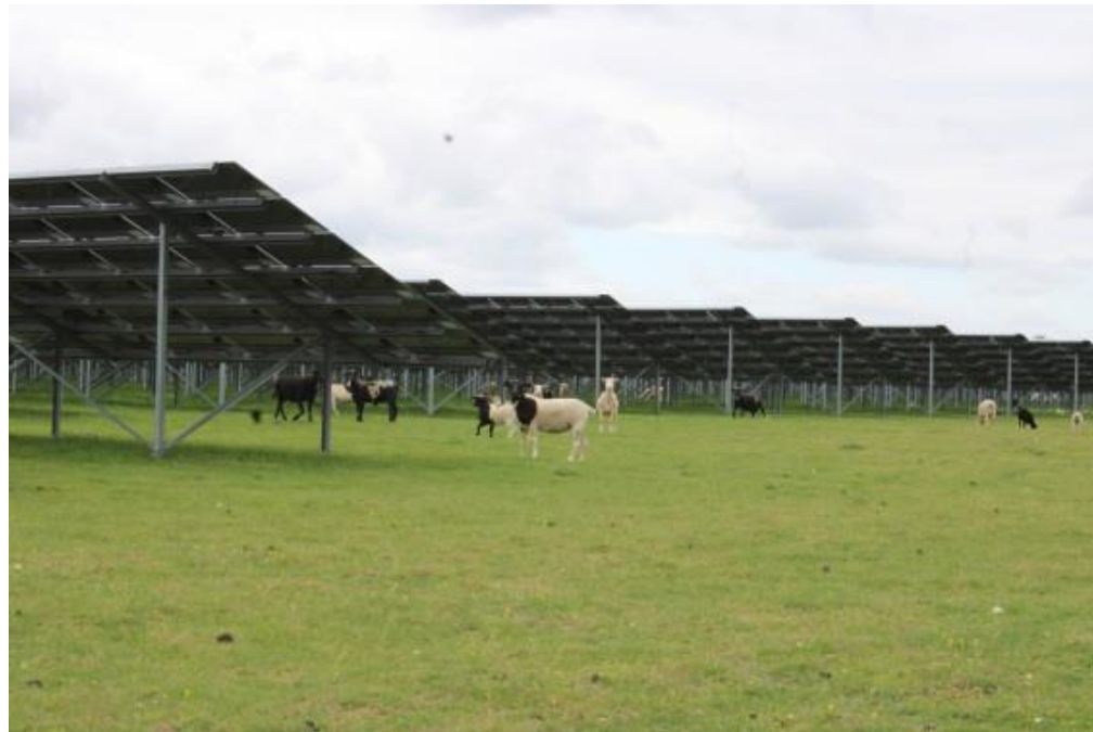
Photo 1 : Le parc photovoltaïque de Verneuil-Charin
