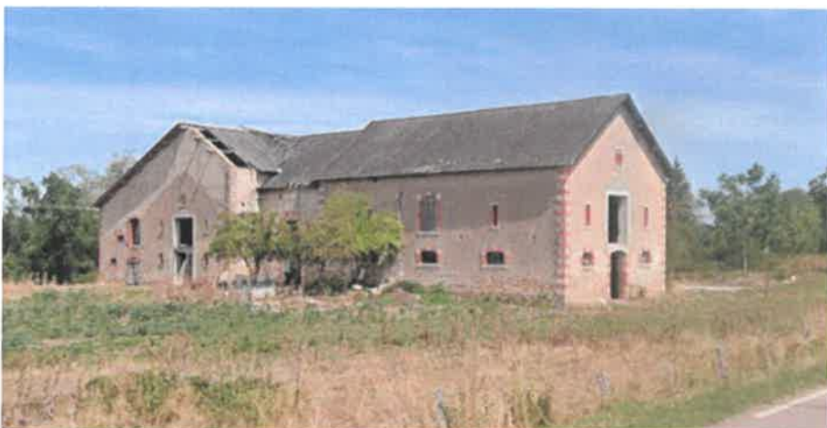
Photo de l'extérieur du bâtiment « La Réserve » Source Google Earth
