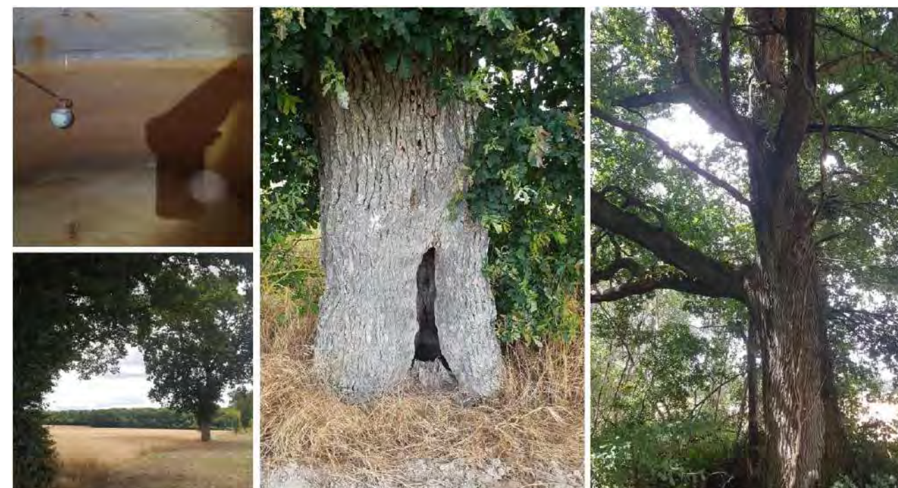
Figure 58 : Potentialités en termes de gîtes à chiroptères des arbres et du bâti de l'aire d'inventaires (réservoir d'eau, lisière, vieux arbres) (source : CREXECO / VERTICALIA / CART&CIE, 2021)
