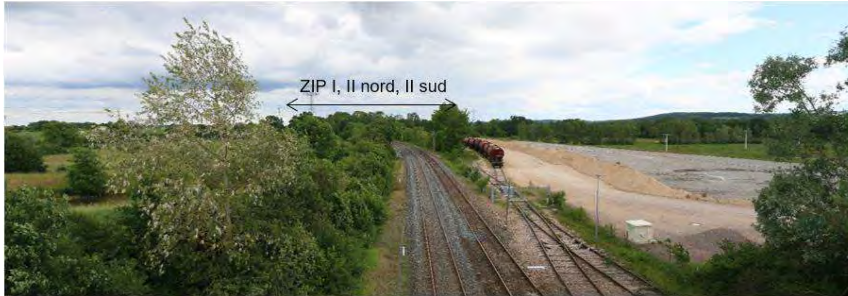
Figure 18 : Photo 16 / Vue sur la ligne de chemin de fer au Sud de Nevers (ATER environnement, 2019)
