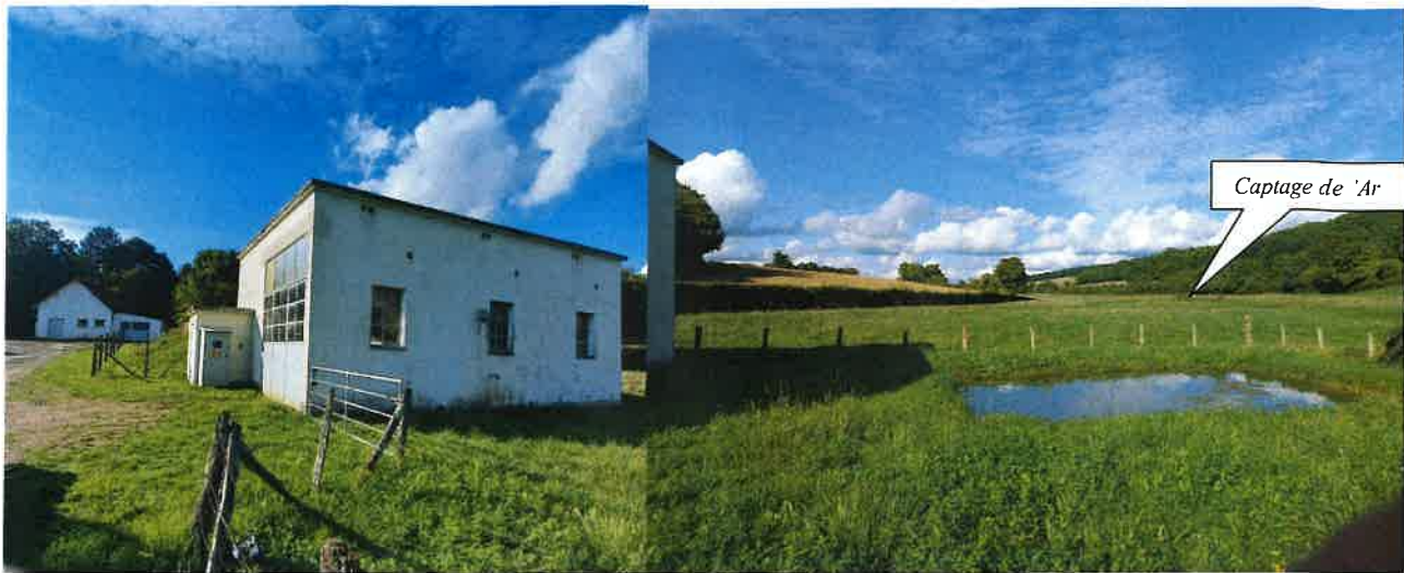
Traitement de l'eau
