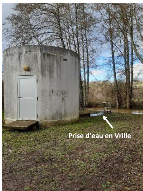
Figure 3-1 : Photographies de la prise d'eau (février 2020)
