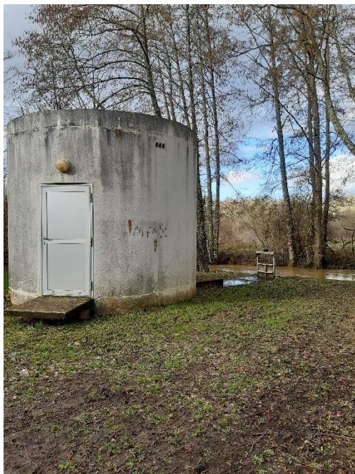
Figure 3-1 : Photos de la prise d'eau (février 2020)
