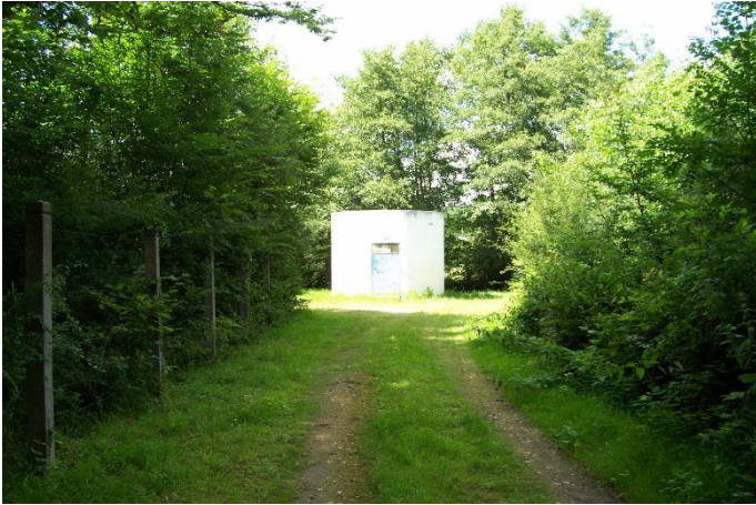
Vue sur le périmètre immédiat
