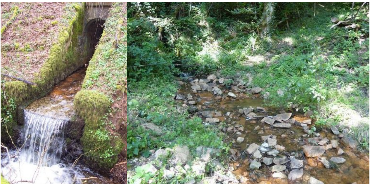
Photo. Rampe en enrochement pour effacer une chute d'eau
