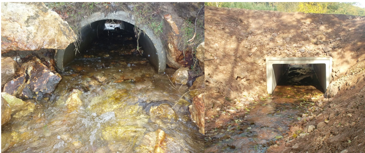
Photo. recalage de buse , dalot en U
