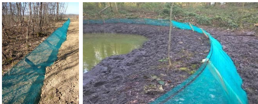
Figure 39 : Illustration d'un dispositif anti-amphibiens se maintenant de lui même
