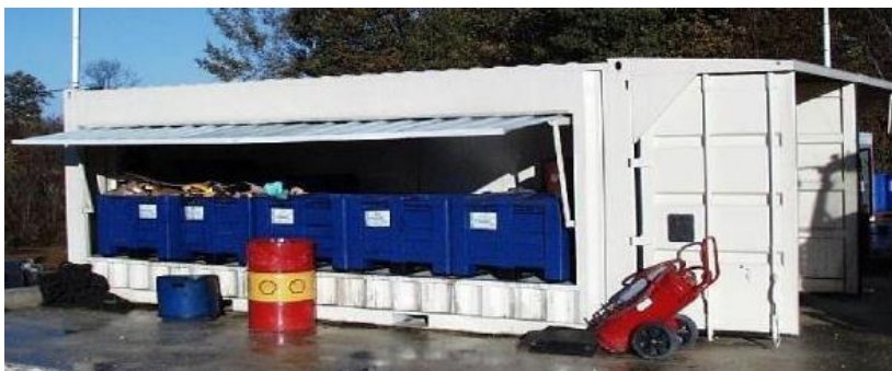
Tri sélectif des déchets de chantier
