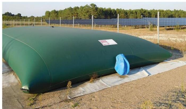
Figure 29 : Réservoir souple incendie
