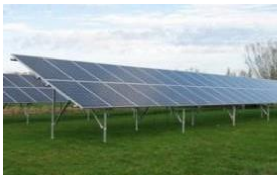
Figure 5 - ancrage par pieux battus
