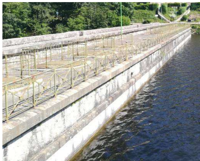
Figure 125 : Débord disponible pour garde-corps provisoire
