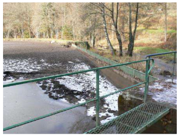
Déversoir équipé de la grille (2008)
