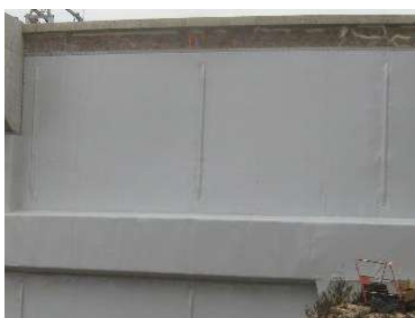
Figure 119 : Etanchement du barrage de Pont-et-Massène (fixations au droit des irrégularités)
