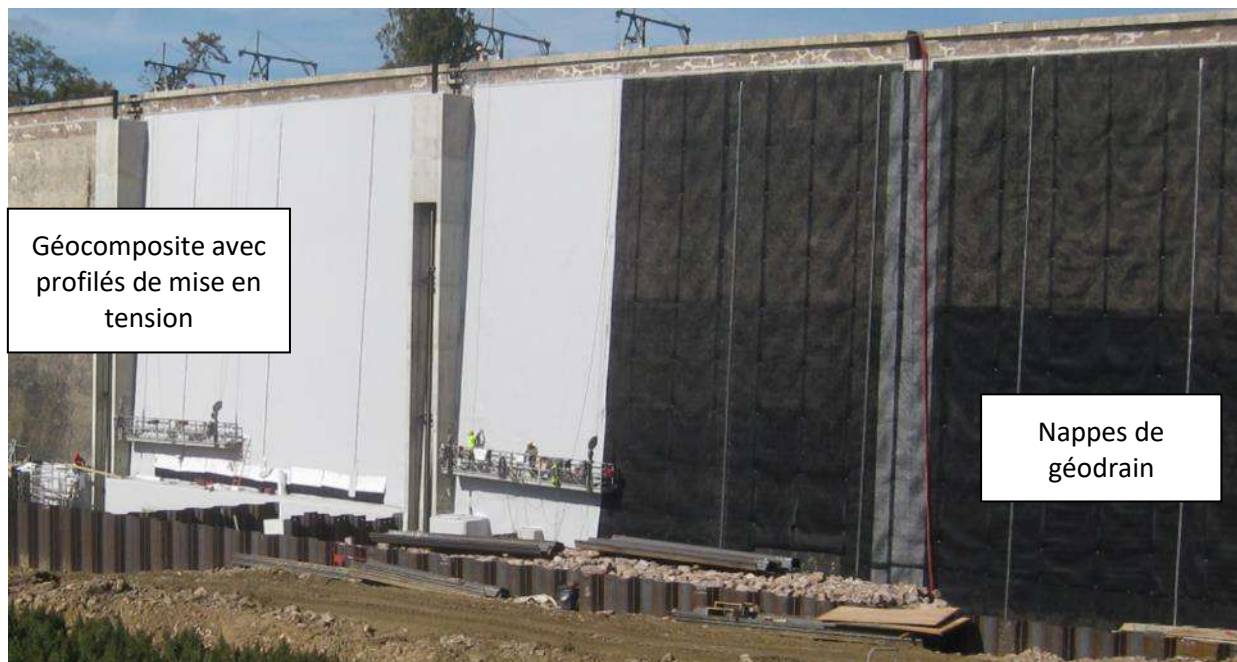
Figure 121 : Exemple de déroulé d'un chantier de pose (Barrage de Pont-et-Massène)
