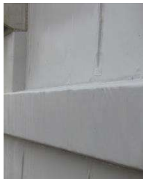
Figure 119 : Etanchement du barrage de Pont-et-Massène (fixations au droit des irrégularités)
