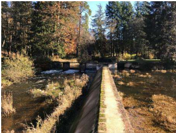
Déversoir du bassin principal (2021)
