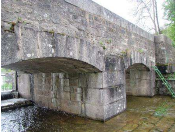
Figure 112: Seuil et coursier de l'évacuateur de crues : zones déjointoyées
