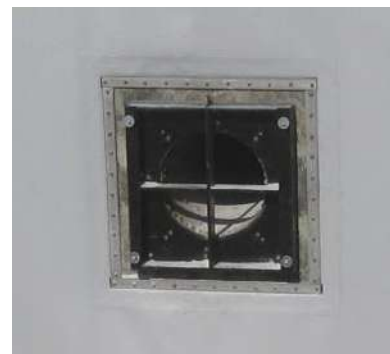
Figure 119 : Etanchement du barrage de Pont-et-Massène (fixations au droit des irrégularités)
