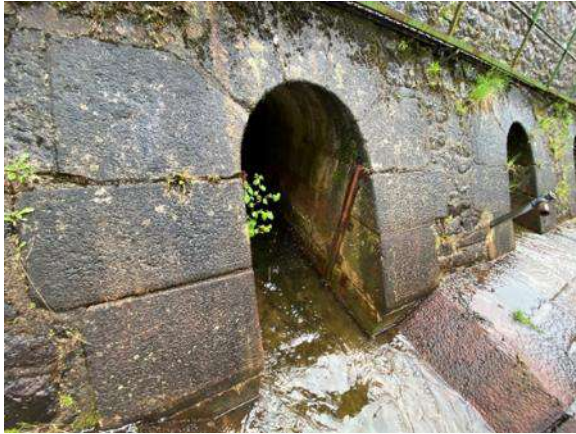
Figure 115 : Epanchoir n°1 (tour de prise) : pertuis et berge rive gauche
