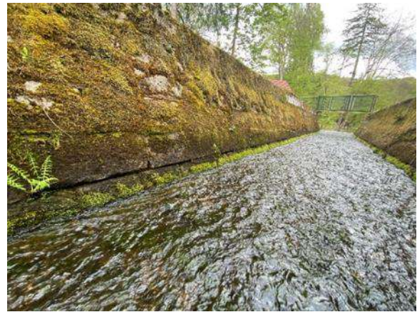
Figure 113 : Seuil et coursier de l'épanchoir n°3
