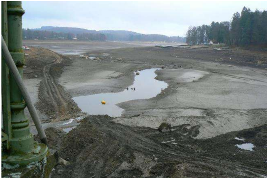
Figure 93 : Batardeau lors des travaux de 2008 (Source : CAEI, vidange 2008)
