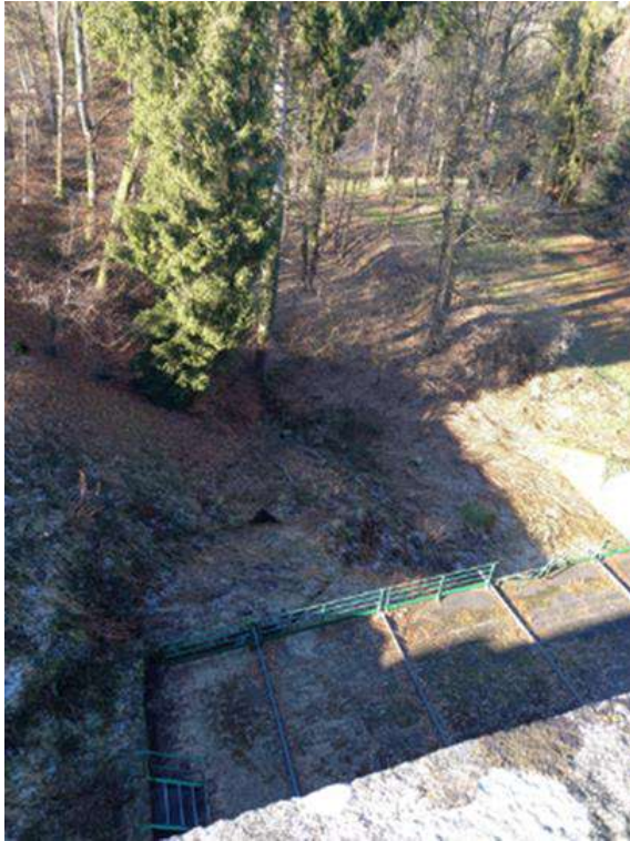
Vue de l'ancien chenal de l'épanchoir n°2
