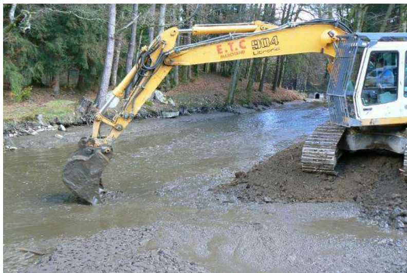
Travaux de nettoyage du "canal de fuite" en aval du barrage 2008, cliché CAEI
