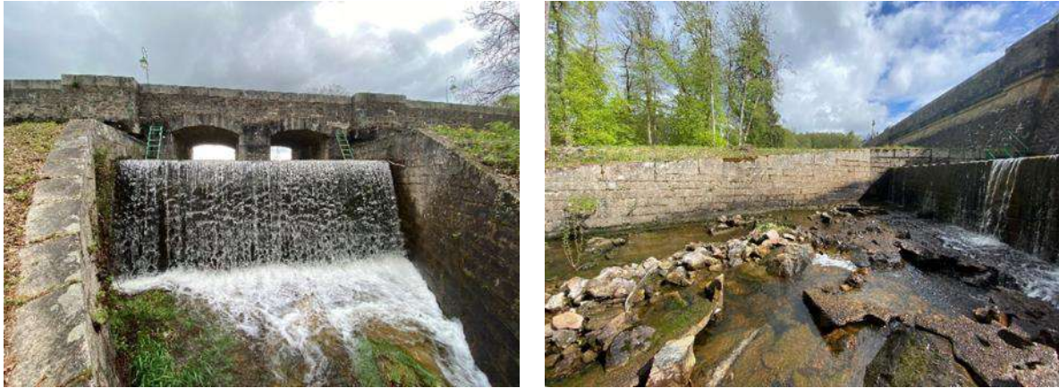
Figure 118 : Entonnements de l'évacuateur et de l'épanchoir n°3
