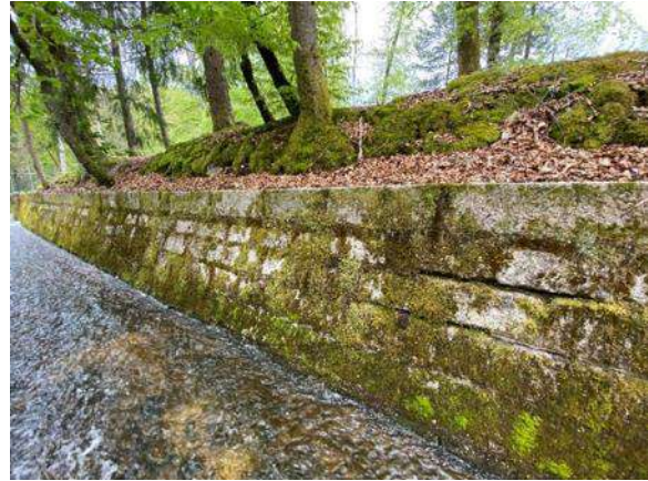
Figure 112: Seuil et coursier de l'évacuateur de crues : zones déjointoyées
