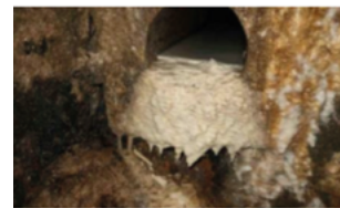
Un drain avant nettoyage
