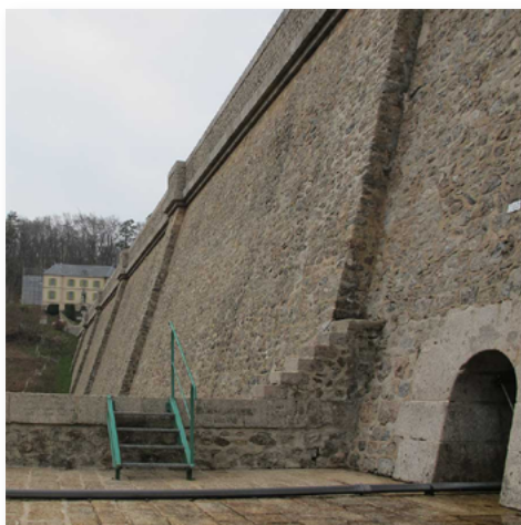
Nettoyage du parement aval
