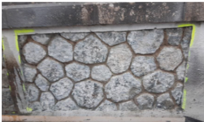
Reconnaissance des maçonneries historiques sous l'enduit existant
