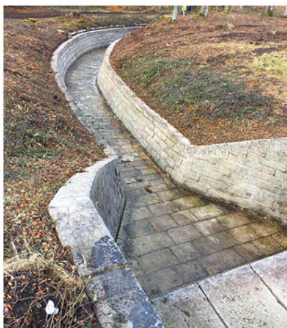
Nettoyage du coursier de l'évacuateur de crue
