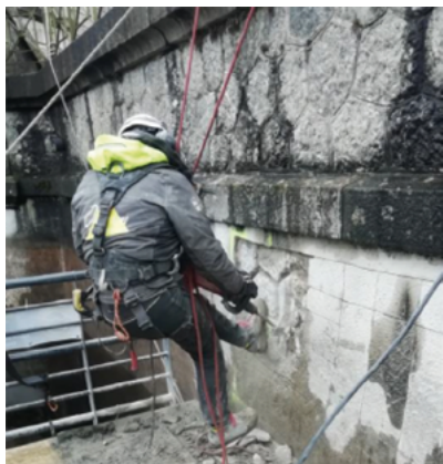
Reconnaissance des maçonneries historiques sous l'enduit existant
