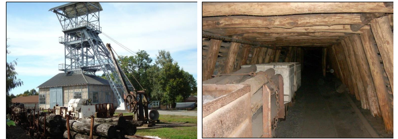
Figure 105 : Puits des Glénons
