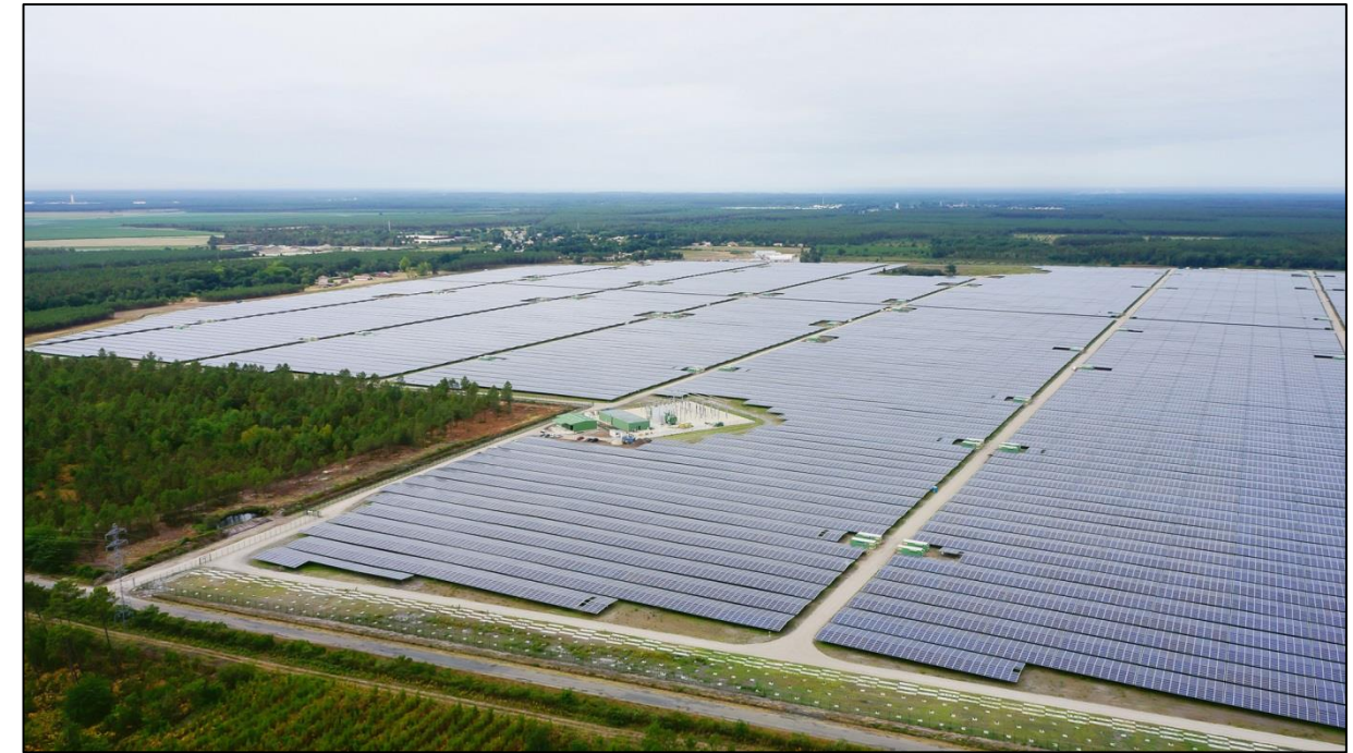
Figure 4 : Vue aérienne de la centrale de Cestas
