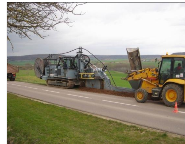
Figure 21 : Réalisation d'une tranchée
