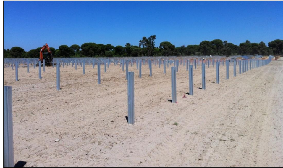
Figure 26 : Exemple des pieux battus dans le sol, la batteuse est visible à l'arrière-plan
