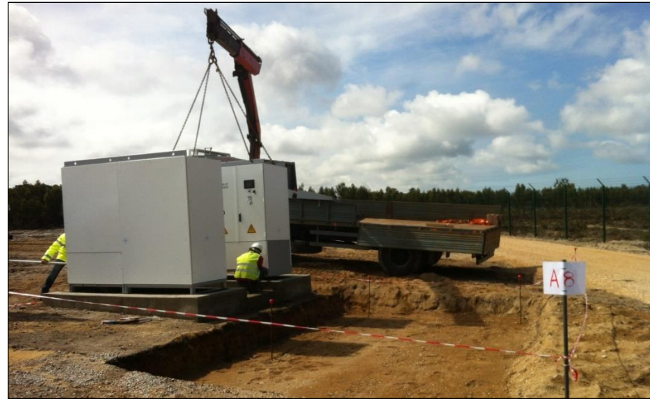
Figure 29 : Installation des postes de conversion
