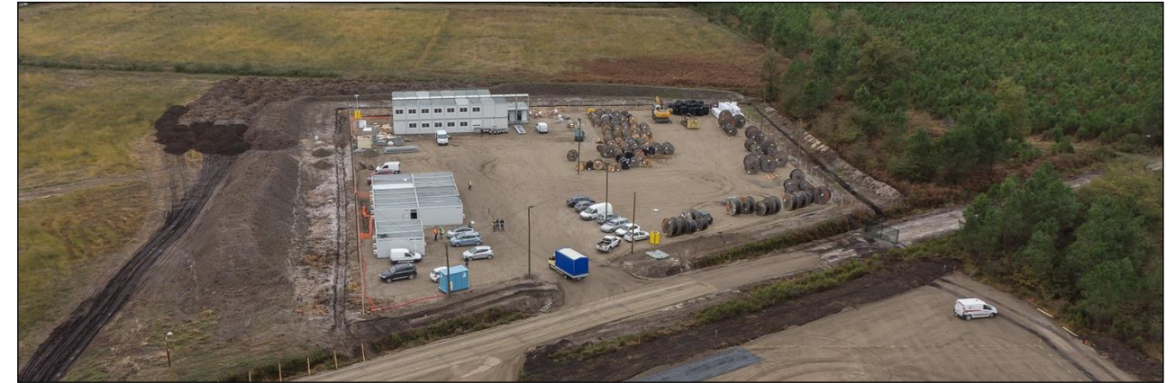
Figure 30 : Exemple de base de vie
