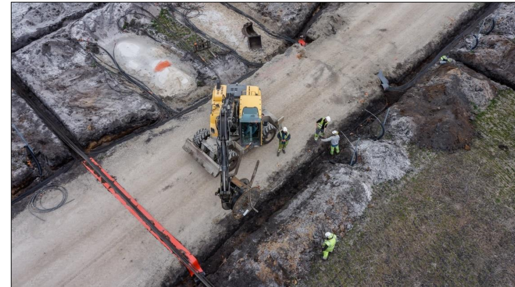
Figure 25 : Mise en place des câbles souterrains
