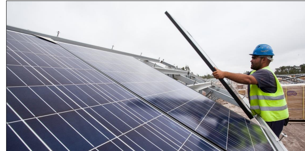
Figure 28 : Exemple de procédé de pose de modules
