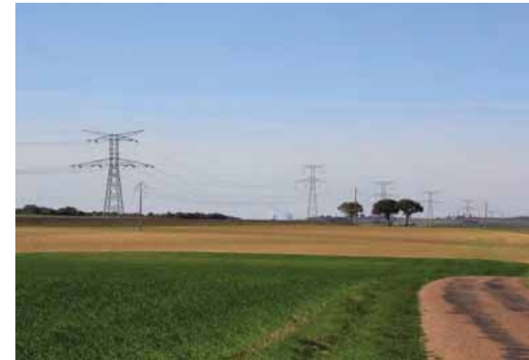
Photo 102 : Ligne électrique 400 kV et 63 kV traversant le site Sud
