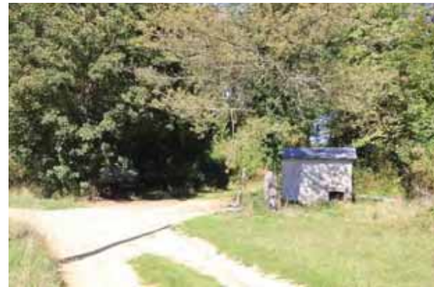
Photo 57 : Prise de vue n°10 : Station de pompage incluse dans la partie Nord de l'aire d'étude rapprochée
