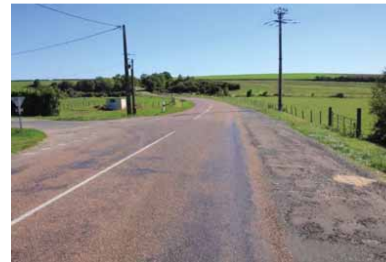
Photo 103 : Ligne électrique 20 kV longeant la RD 33
