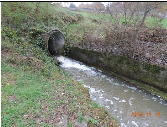
Figure 13 : Vue du ruisseau des Frossards – aval immédiat de l'ouvrage sous la RD907
