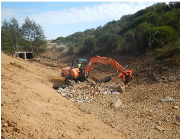
Recharge granulométrique et mise en place d'un seuil de fond
