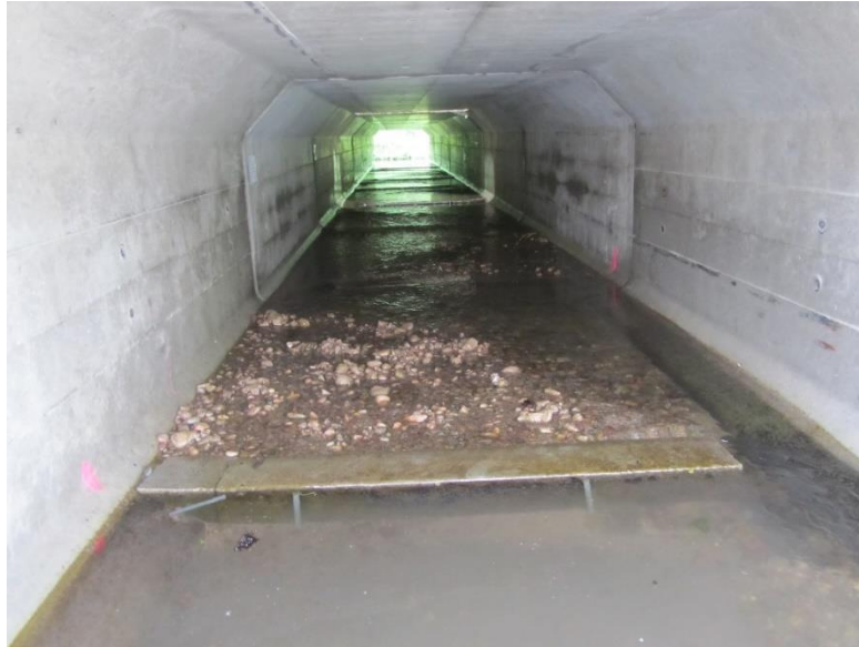
Figure 6 Exemple de réalisation Ruisseau du Crible (70)
