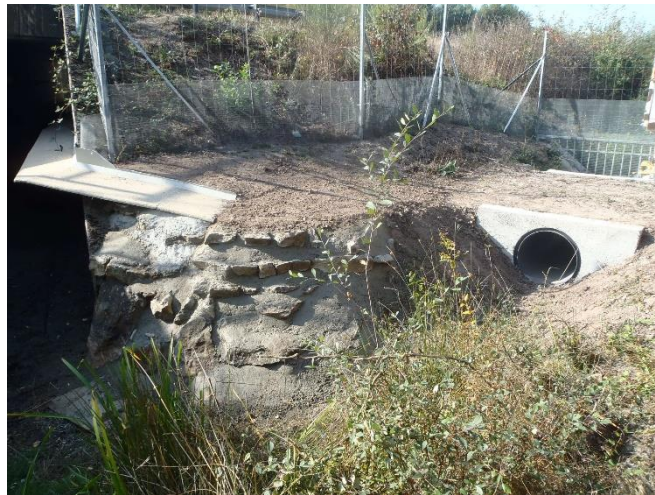
Figure 9 Rampe de raccordement entre la banquette et la berge, (Vinci Construction Terrassement 2018)
