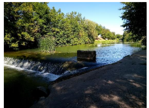
Figure 17: Seuil Canal de dérivation à Nevers
