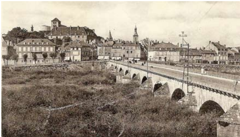
Decize au début du XXème siècle : le lit de la Loire est envahi par la végétation. Les réseaux électriques sont accrochés au pont.
